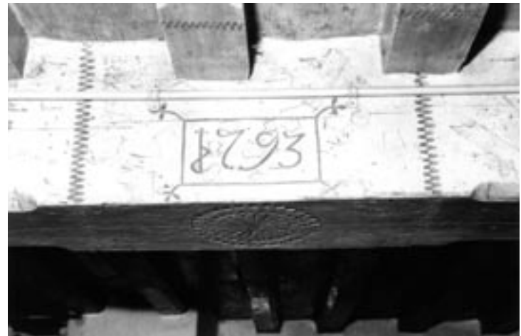
Abb. 290: Der Durchzugbaum des Hauses Brandeben 5 (Koller) besagt, dass das Haus 1793 erbaut wurde (Foto Marsam).
