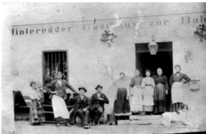
Abb. 48: Das Gasthaus der Bergwerksbesitzer Balthasar und Maria Hinteregger auf Kreuztanne 8, Gem. St. Anton, nannte sich nach dem Bahnbau „Gasthaus zur Bahn“ und hieß bis zu seiner endgültigen Schließung Ende des 20. Jahrhunderts einfach „Kreuztanne“; Aufnahme zwischen 1907 und 1914 (Slg. Hans Reisenbichler, Weinzierl bei Wieselburg).
