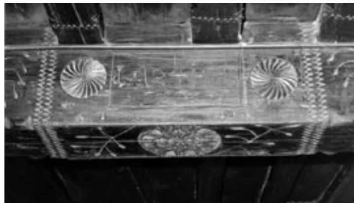
Abb. 18: Der im Jahre 1724 errichtete Durchzugbaum im Bauernhause Flach erinnert an die oben beschriebene Zeit; 17. Aug. 1984 (Foto Marsam).
