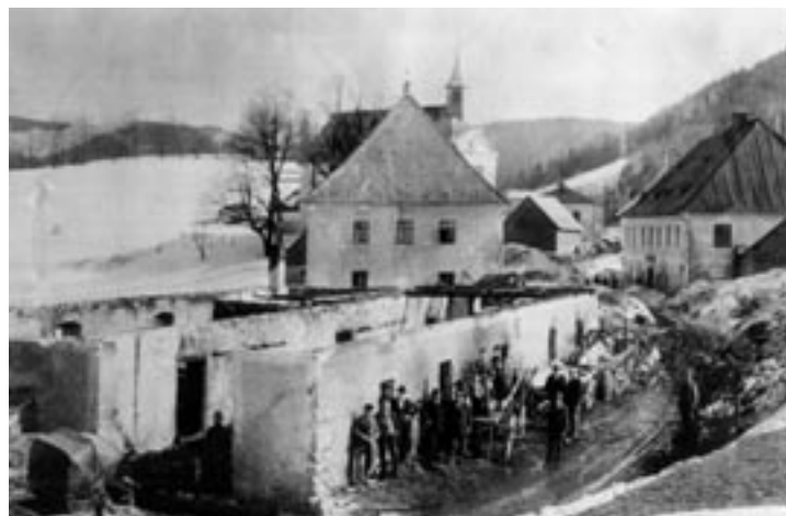
Abb. 71: Abgebrannter Stall des Gasthauses Lawitschka (Taverne Nr. 4, heute Halterhof) im Jahre 1905; rechts die Taverne Nr. 4, gegenüber das Haus Nr. 3 (Herrschaftshaus), dahinter der Schuppen vor der Kirche, links die Kirche, rechts dahinter das Gemeindehaus Nr. 16 (Slg. Volksschule).
