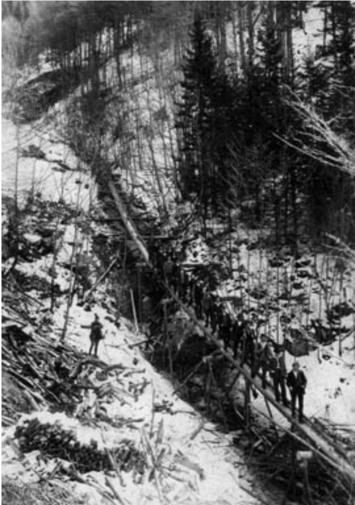
Abb. 101: Holzarbeiter auf einer Holzriese im Ötschergebiet. Dieses Bild diente offensichtlich Lorenz Peter Herzog als Vorlage für die Zeichnung auf Seite 9 seines Büchleins „Unsere Holzknechte“ (Slg. Höbl/Gansch, Frankenfels).
