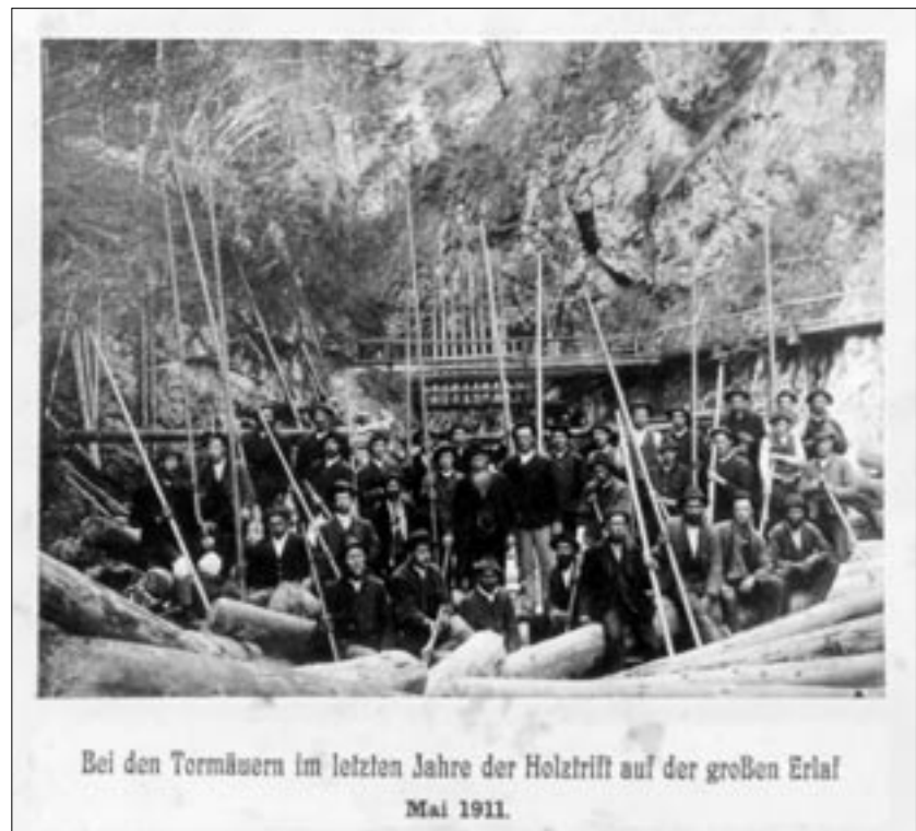
Abb. 100: Der 1847 genannte – aber sicher ältere – Holzrechen beim Toreck (im Hintergrund des Bildes) diente zum Auffangen und Sortieren des Triftholzes. 48 Bei günstigem Wasserstand ließ man dann das Holz partienweise weiter. Dieses Foto wurde bei der letzten Erlauftrift im Mai 1911 aufgenommen. Die langen Stangen (Flötzbeile) hatten an einem Ende einen waagrechten und einen senkrechten Dorn zum „Anspießen“ des Holzes (Slg. Franz Buder, Mitter-Toreckhüttenhäusl).
