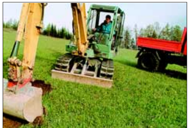
Abb. 16: Vorsichtiges Abtragen des Kalkmagerasens in ca. 60 x 80 cm großen, 10-15 cm dicken Wiesenstücken, mit dem Kleinbagger und Verladen auf den Unimog, welcher an diesem Tag 35 Fuhren zur Ersatzfläche brachte.
