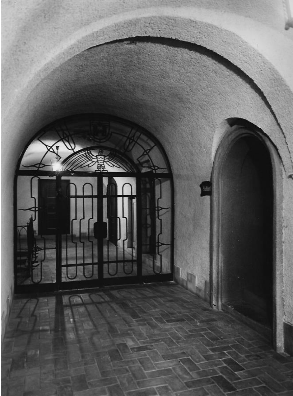
Rathausumbau Bild 4 Vermerk: Rathaus Gang I.St. 1940, No 12631
