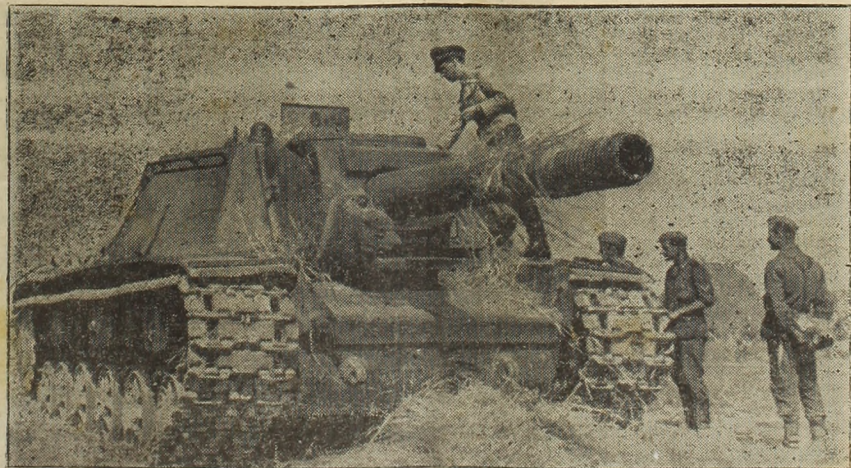
Dieser gewaltige Koloss, ein sowjetisches Sturmgeschütz mit 15,2-Zentimeter-Kanone und 10-Zentimeter-Stirnpanzerung, wurde von einem unserer Sturmgeschütze mit drei Panzergranaten außer Gefecht gesetzt. (P.R.-Aufnahme: Kriegsberichterstatter Dreher, 55., 3.)
