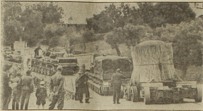
Eine Panzerkugel wird zur Baustelle transportiert. Bei Steigungen reichen oft die Zugmaschine und ein Panzer nicht aus. Da muß dann noch ein zweiter Panzer, der sonst hinter dem Spezialfahrzeug angehängt ist, und durch Stoppen und Zurückziehen bei abfallendem Gelände die Transportschwierigkeiten ausgleicht, vorgespannt werden. (P.A.-Aufnahme: Kriegsberichtler Werner, P.B., 3.)
