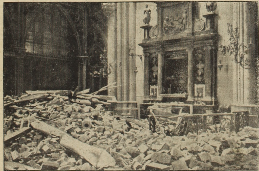
Die Zerstörungen im Kölner Dom durch die britischen Luftpiraten. Wie der ORW-Bericht vom 29. Juni meldete, erlitt bei dem Terrorangriff, den die britische Luftwaffe nachts gegen die Stadt Köln führte, auch der Kölner Dom schwere Spreng- und Brandbombenschäden. Das Kölner Rathaus, das Stadthaus und der aus dem frühen Mittelalter stammende Saalbau der alten Hansestadt, der Gürzenich, wurden völlig vernichtet. — Links oben: Der Kölner Dom, eines der großartigsten Bauwerke im deutschen Hochgotik (Atlantisch, Zander-Mk.). Rechts oben: Das durch seinen reichen Figurenschmuck bekannte Kölner Rathaus (Atlantisch, Zander-Mk.). Oben: Die Zerstörungen im Kölner Dom. Der Drei-Königs-Altar mit der schwarzen Muttergottes, die allabendlich in Sticherheit gebracht wird und deshalb verschont blieb (Atlantisch-Hülbsbuch, Zander).
