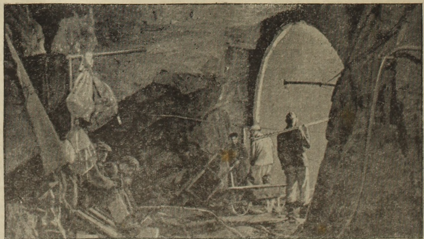
Der Atlantikwall. Viele der Bauten, die die Festungspioniere planen, werden in Erde und Fels getrieben. In solchen Fällen ist die Erfindung des Geländes und die Festlegung der Baupläne, die Hauptarbeit des Festungspioniers, besonders schwer.
