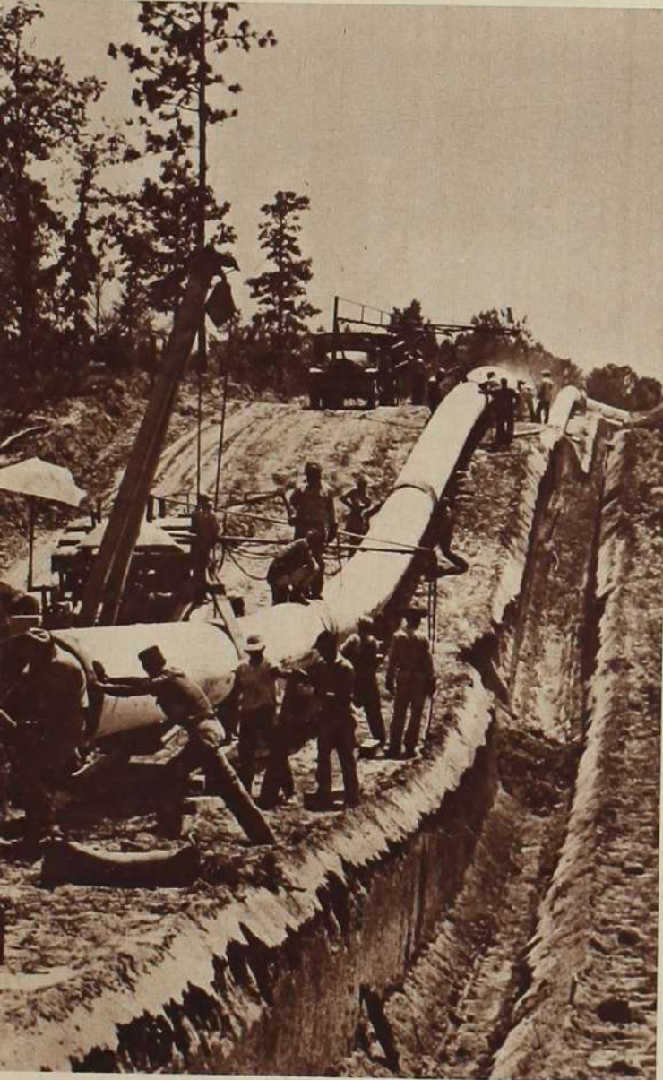
36-zölligen Rohre werden zusammen- schluß mit Gammastrahlen durchleuchtet.
