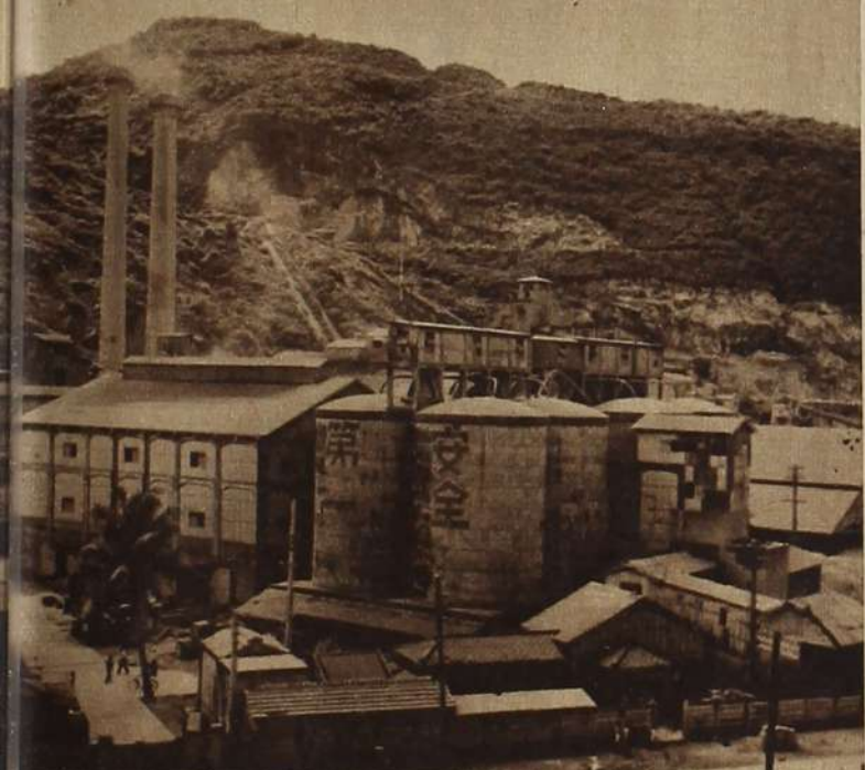
Ein kalorisches Kraftwerk auf Formosa. Mit Unter- stützung durch die Regierung und die Amerikahilfe wurde die Wirt- schaft Formosas durch die Errichtung dieser Anlage angekurbelt und der Lebensstandard der Bewohner der Insel wesentlich gehoben.
