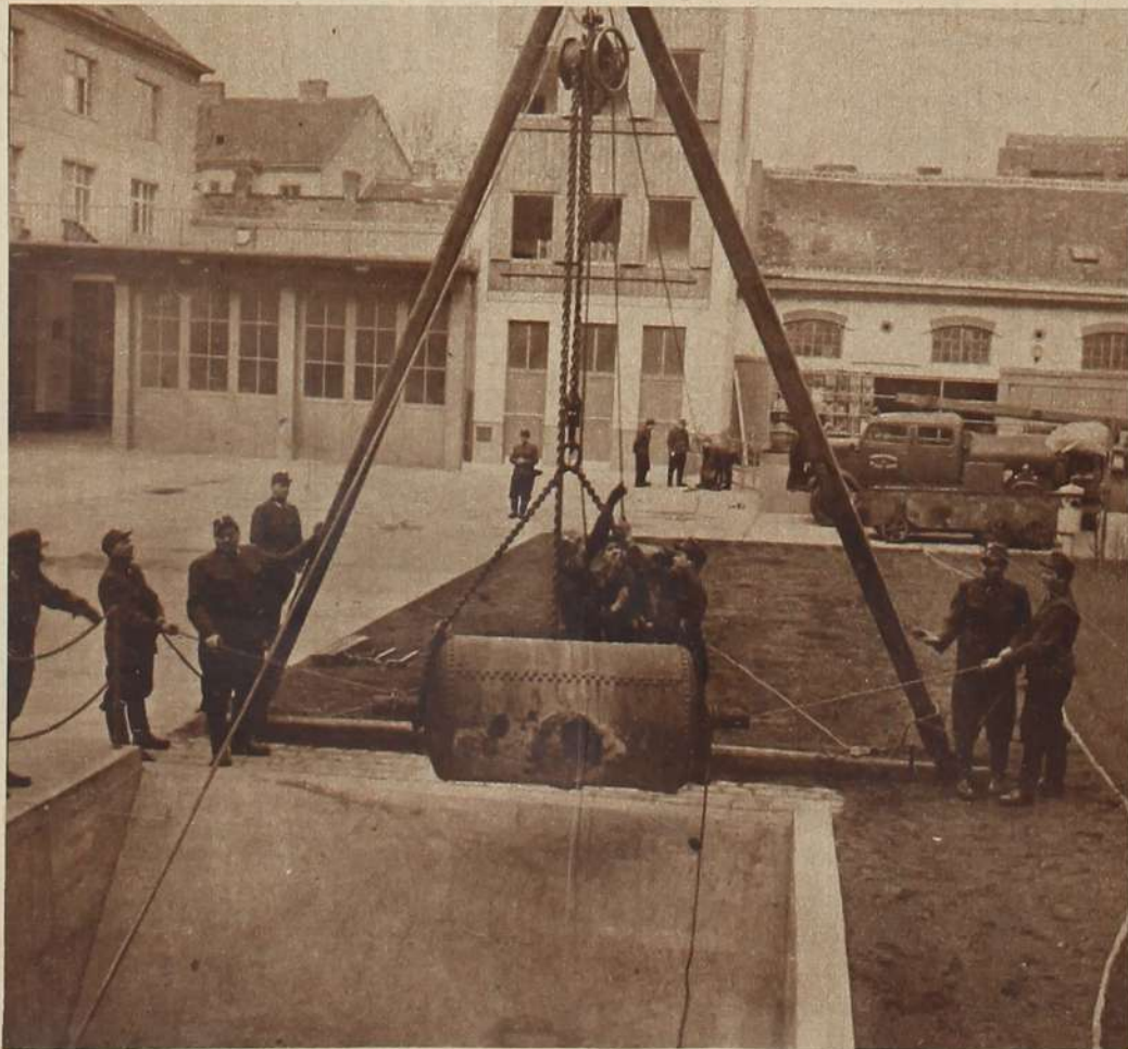
Das Heben von Schwerlasten auf tieferliegendem Gelände wird an der Übungsgrube im Hof der Hauptfeuerwache geübt. Die Feuerwehrleute müssen ihre Arbeitsgeräte bis ins kleinste Detail mit absoluter Sicherheit beherrschen, um jederzeit und überall einsatzfähig zu sein.
