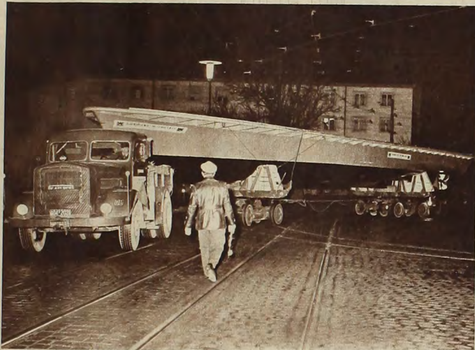
EIN SCHIFF FÄHRT DURCH MÜNCHEN — allerdings nicht zu Wasser, sondern auf Tiefladewagen. Es ist das 25 m lange Doppelschrauben-Dieselschiff „Herrsching“, das auf diese Weise zum Ammersee transportiert wird, wo es den fehlenden Oberteil erhalten soll.
