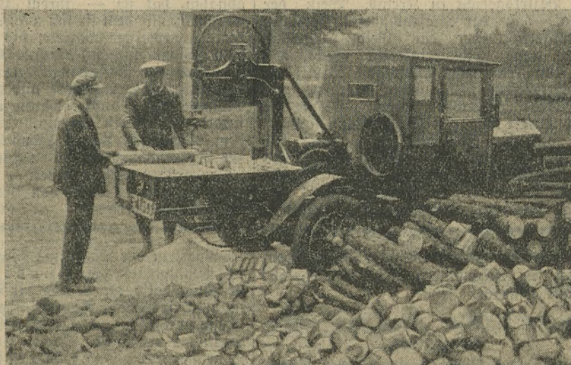
Pflaster aus Brennholz. In Berlin werden jetzt Versuche mit einem neuartigen Pflaster gemacht. Ganz gewöhnliches Holz wird in Klöße zerschnitten, dann verlegt und mit einem geeigneten Bindemittel versehen.
