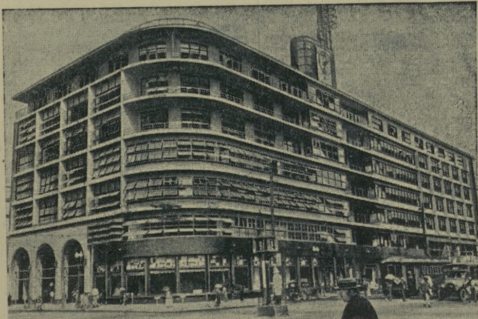
Dieses Warenhaus in der japanischen Hauptstadt Tokio ist am 16. Dezember vollkommen niedergebrannt. Es sind 14 Tote und 110 Schwerverletzte zu beklagen. Das Warenhaus ist erst vor kurzer Zeit fertig geworden.
