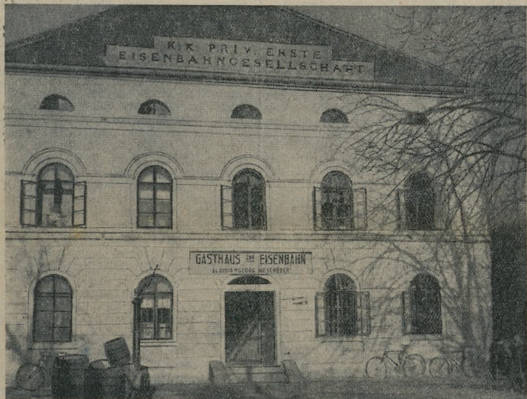
Ehemaliges Stationsgebäude der Pferdebahn Linz—Gmunden in Březová bei Linz.
