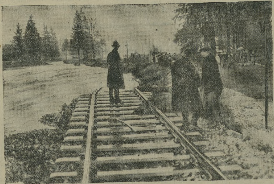
Das überaus milde Winterwetter der vorigen Wochen hat den Schnee im Gebirge zum Schmelzen gebracht. Die rasche Schneeschmelze verursachte in den Alpenländern, aber auch in Deutschland Ueberschwemmungen. Hier sehen wir die überflutete Bahnstrecke Goslar-Clausthal. Sie wurde bei Lindthal überflutet und unterwaschen. Man braucht mehrere Tage, um die Strecke wieder fahrbar zu machen.
