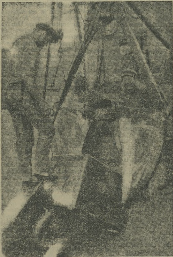
Auf der Suche nach dem Postbeutel des britischen Außenamtes und den Schlüsseln zum Barrenraum des gesunkenen Dampfers: Der Saft des Kapitäns der „Egyp“, im Gewichte von ungefähr einer halben Tonne, wird durch kreisartige Haftschere zu Tage gefördert.
