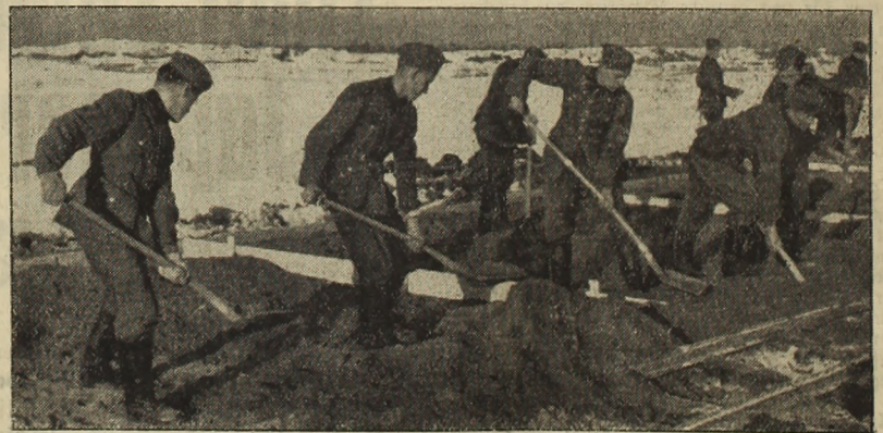
RAU-Einsatz im Osten. Ein Anschlussgleis in deutscher Normalspur muß zu einem Feldflugplatz im Osten gelegt werden. Arbeitsmänner nehmen die notwendige Aufschüttung vor.
