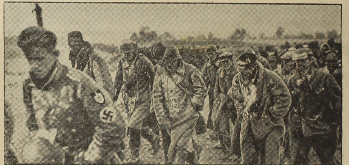
Der RAD ist überall dabei. Es ist ein harter und entfangungsvoller Dienst, bei diesem Wetter, wo der eisige Wind den Schnee in die Gesichter treibt, Brücken zu bauen und Gefangenentransporte über Land zu führen. Aber der Reichsarbeitsdienst ist stolz darauf, bei diesen Aufgaben der Wehrmacht ein treuer Helfer zu sein. (P.R.-Aufnahme: Kriegsberichter Wendlinger, RAD, 3.)
