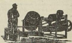
So wie hier der Hund Milchseparator und Butterfaß treibt, lassen sich in leichter Weise folgende Maschinen anhängen: Pumpe, Trieur, Schrot- und Ruzmühle, Rübenschneider, Knochenbrecher, Eiszerkleinerer, Fleischschneider, Schleifsteine, Gebläse, Säge, Drehbank, Bohrmaschine, Waschmaschine, Mischwerke u. a. m.
