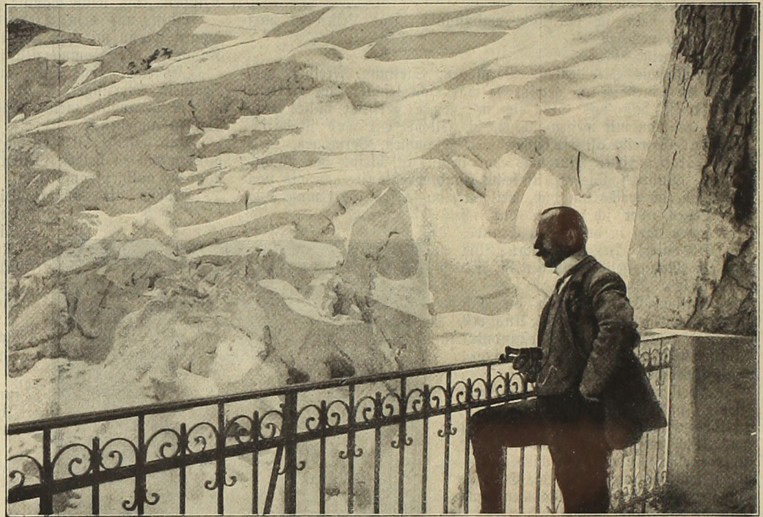
Vom Bau der Jungfraubahn: Ansicht von der Station Eismeer auf die Gletschergebilde.
