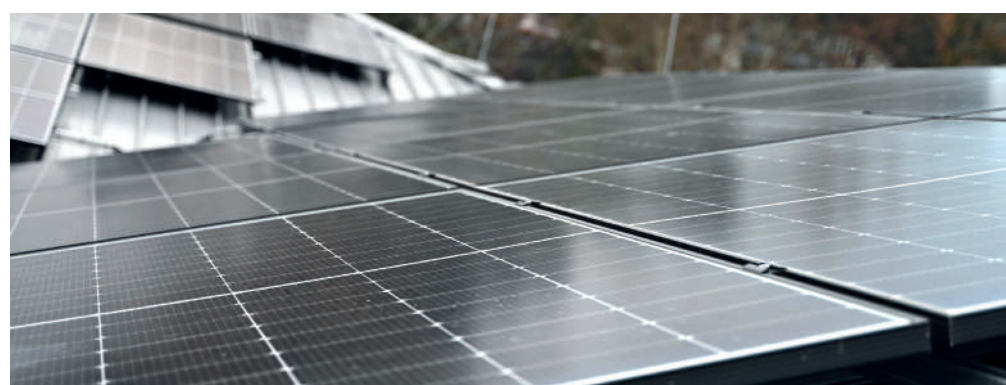
Auf dem Dach der Kläranlage wurde die PV-Anlage erweitert und erreicht nun eine Gesamtleistung von 112 Kilowatt.
