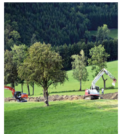
Circa vier Kilometer Wasserleitung werden aktuell gegraben.
