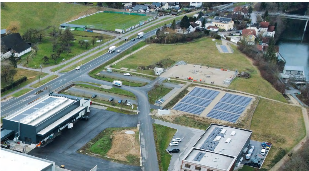
Hier in Kreilhof wird das neue Feuerwehrhaus für die künftige Freiwillige Feuerwehr Waidhofen an der Ybbs entstehen. Demnächst startet das Planerauswahlverfahren.
