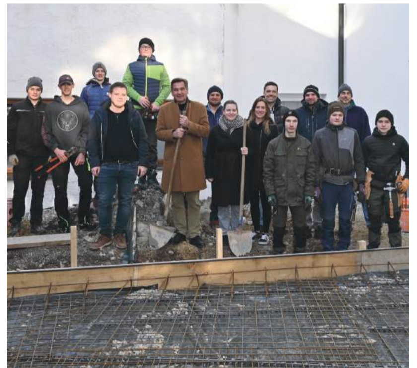
Der Fachbereich Bau/Holz der Polytechnischen Schule Waidhofen errichtet derzeit in Kooperation mit heimischen Unternehmen einen Bauplatz am beta campus, der künftig für den praxisnahen Unterricht genutzt wird.
