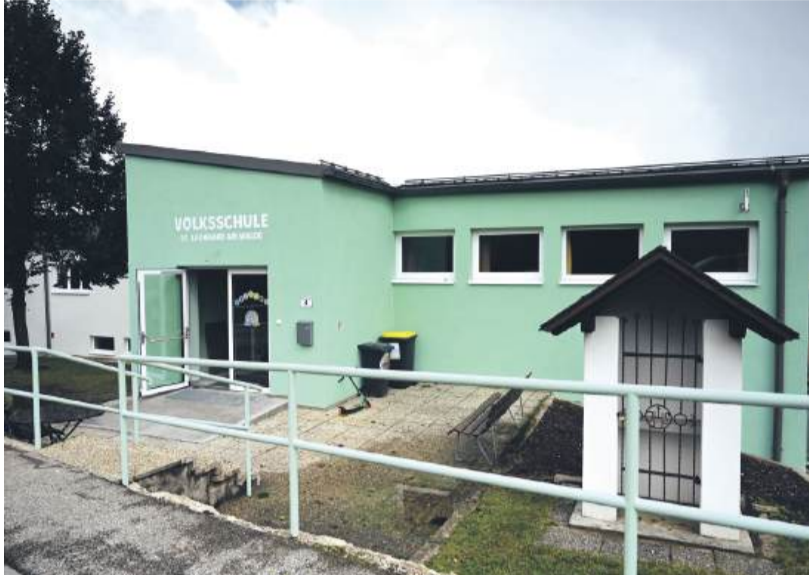
Mit neuer Fassade, umweltfreundlicher Dämmung und einer Photovoltaikanlage setzt die Schule auf Energieeffizienz und Nachhaltigkeit.
