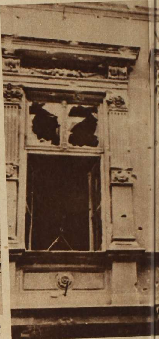
Das Hauptgebäude des ungarischen angegriffen und schwer beschädigt. In Verteidigern im Stich gelassen wurde Häuserfronten, ausgebrannte Fahrzeu-
