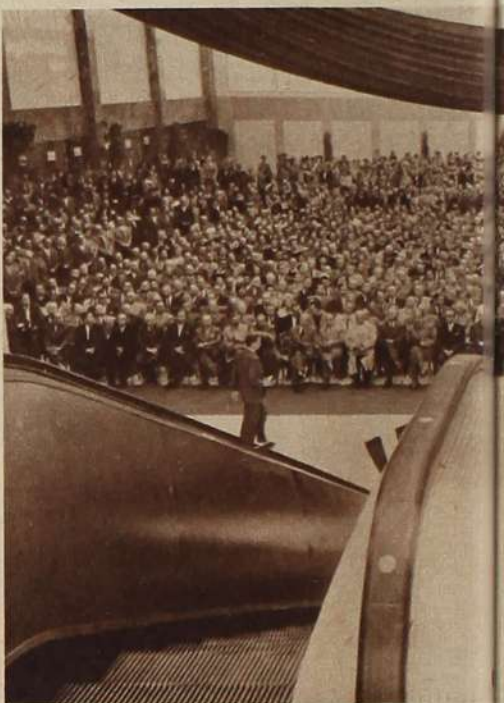
Zur festlichen Eröffnung des neuen Südbahnhofes ein ebenso zahlreiches wie prominenter Besuch. Die Treppe zu den Bahnsteigen im ersten Stock.
