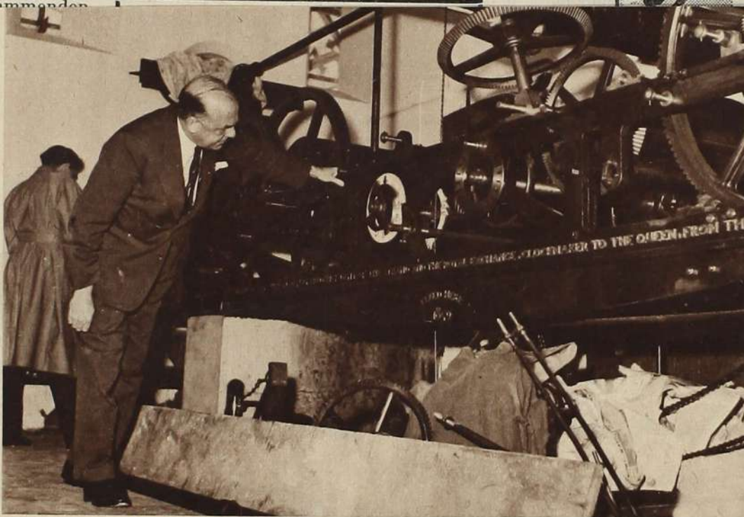
Das riesige Werk der Turmuhr des Westminster-Palastes in London wurde zerlegt und nach der Überholung neu zusammengesetzt. Deutlich zeigen die blankgeputzten Beschriftungstafeln die Jahreszahl der Aufstellung: 1859.
