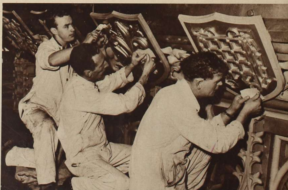
Wirklich „auf Glanz geputzt“ wird auch die Außenseite des Turmes. Für die Neuglasung der Zifferblätter (links) wurden fast 1000 Glasscheiben benötigt. Oben: Die Neugoldung der Schmiedeeisenteile gehörte ebenso wie die Ausbesserung der Steinmetzarbeiten und der Ersatz von Dachziegeln und -rinnen zur Renovierung des Turmes. — Im Oktober wird die Uhr in Gang gesetzt und der berühmte „Westminsterschlag“ wieder über London erklingen.
