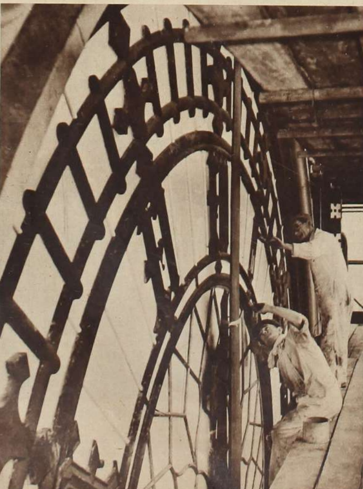
Wirklich „auf Glanz geputzt“ wird auch die Außenseite des Turmes. Für die Neuglasung der Zifferblätter (links) wurden fast 1000 Glasscheiben benötigt. Oben: Die Neugoldung der Schmiedeeisenteile gehörte ebenso wie die Ausbesserung der Steinmetzarbeiten und der Ersatz von Dachziegeln und -rinnen zur Renovierung des Turmes. — Im Oktober wird die Uhr in Gang gesetzt und der berühmte „Westminsterschlag“ wieder über London erklingen.
