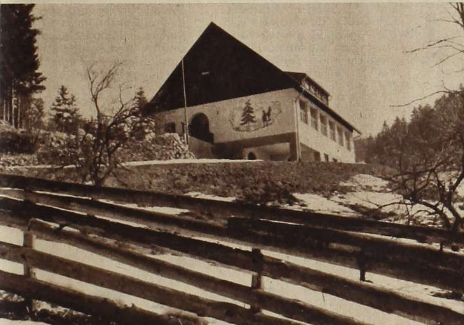
den Bergen Österreichs ist auch die Schule ein Stück Landschaft. Dieses Schulhaus bei Lunz a. See (oben) wurde der heimischen Bauart nachempfunden und bietet so dem bürgerlichen Schüler ein vertrautes Heim. Die Essenzzimmer derartiger Schulen (das Bild rechts wurde in der Schule von Mannersdorf, Bezirk Krems, aufgenommen) sind anheimelnde, den stilvollen Erzeugnissen der Volkskunst eingerichtete Räume, deren Ausstattung einerseits ländlichem Geschmack und Brauchtum, andererseits den Erfordernissen des modernen theoretischen und praktischen Unterrichts Rechnung trägt.
