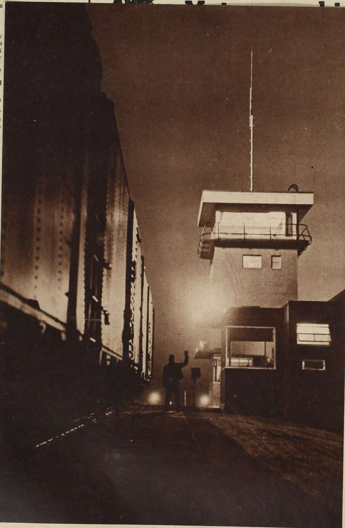
Der Rangierbahnhof Hamlet , Nordkarolina, besteht aus 120 Kilometern Gleisen. Die ankommenden Waggons werden automatisch auf eines der 58 Bestimmungsorte auf das gleiche Gleis kommen. Das Weichenstellen wird
