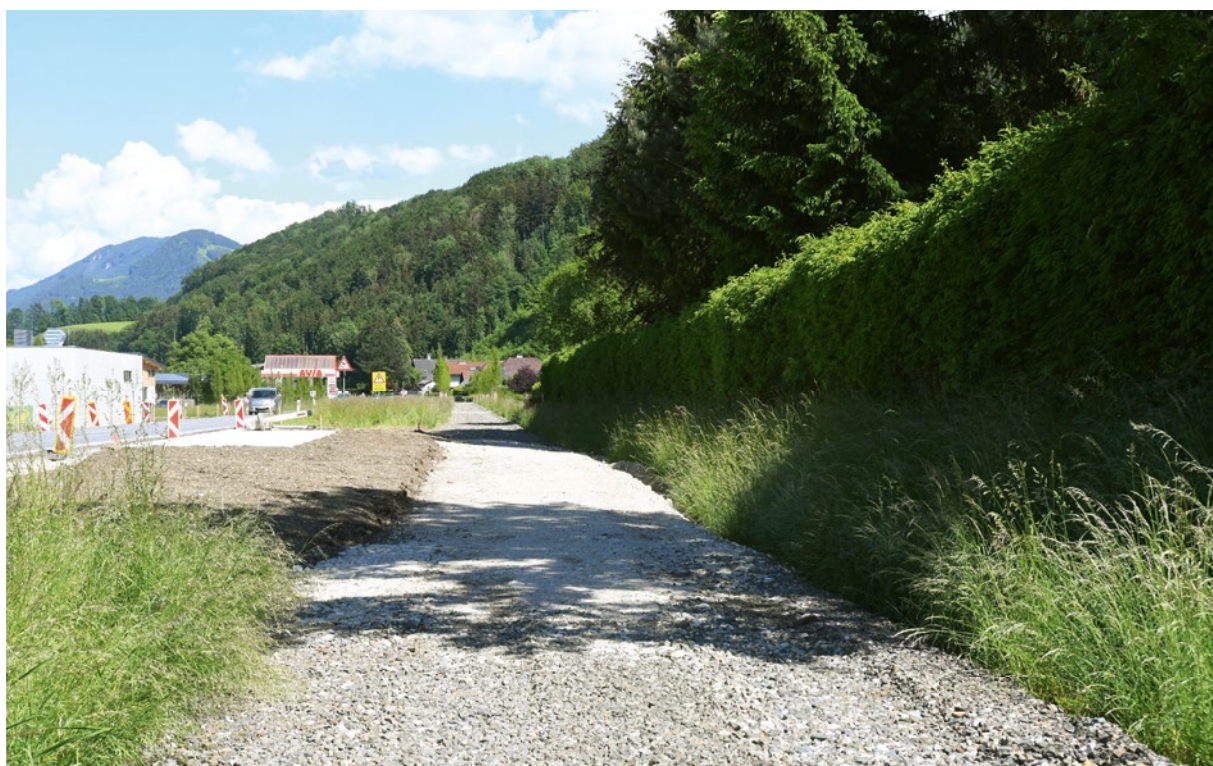
Hier auf der ehemaligen Bahntrasse der Citybahn werden demnächst die Fahrräder Einzug halten. Noch im Herbst ist die Asphaltierung und Fertigstellung des Radweges geplant.
