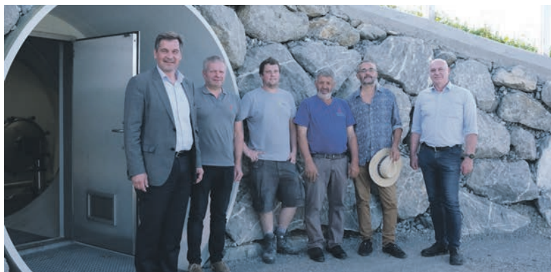
Hochbehälter in Rien: Insgesamt 13 Kilometer Wasserleitungen, drei Pumpwerke und einen Hochbehälter umfasst die Versorgungsanlage in Rien im Endausbau.
