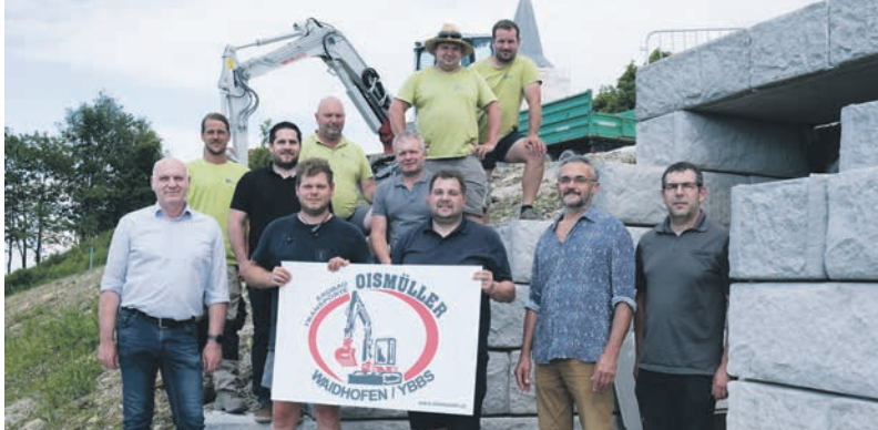
Hochbehälter in Windhag: Rund 20 landwirtschaftliche Anwesen können dank der neuen Anlage sicher mit Trinkwasser versorgt werden.
