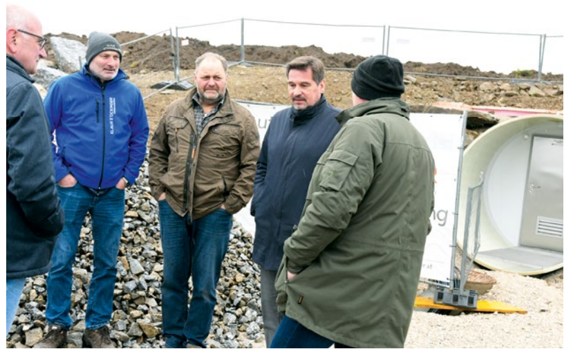
Der Hochbehälter am Arzberg zur sicheren Wasserversorgung des ländlichen Raumes wurde in Kooperation mit der Gemeinde Ybbsitz errichtet.
