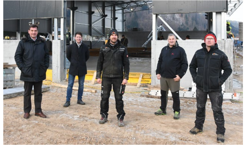
Das Firmengebäude von „HAFO“ im Wirtschaftspark Kreilhof nimmt bereits konkrete Formen an.
