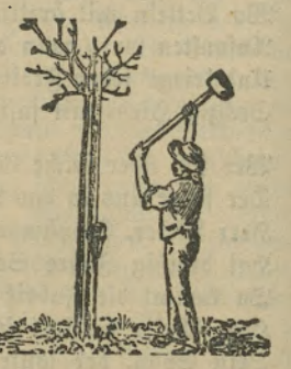
Setzen eines Bannpfahles mit Hilfe des Pfahlreibers.
