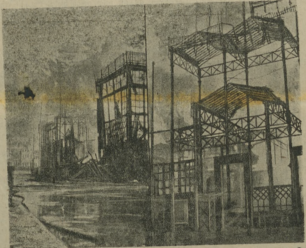
3000 ausgestellte Bilder, darunter viele sehr wertvolle, sind ein Raub der Flammen geworden. Der entstandene Schaden ist kaum abzuschätzen, weil die vernichteten Kunstwerke unerfesslich sind. — Unser Bild zeigt das Eisengerippe des ausgebrannten Glaspalastes.
