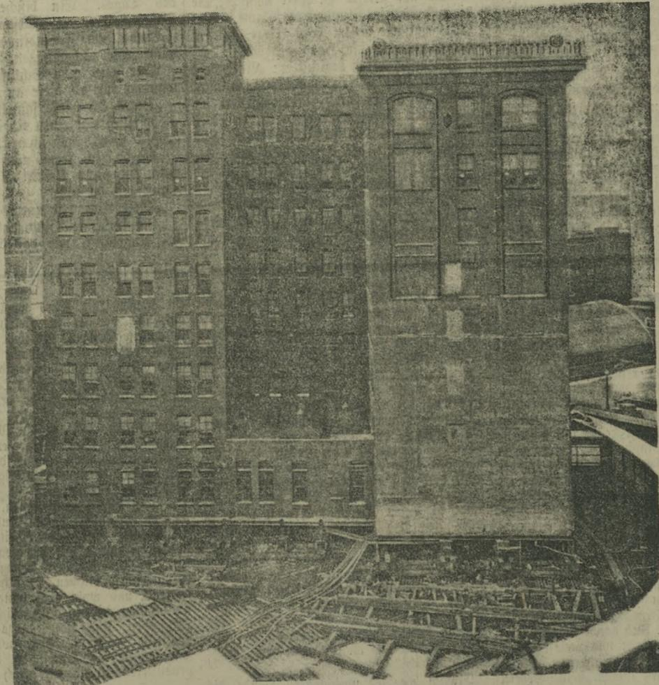
In Indianapolis wird die Telefonzentrale verlegt. 18 Mann arbeiten an riesigen Maschinen. In der Stunde „verschiebt“ sie das Haus um 1 Meter.
