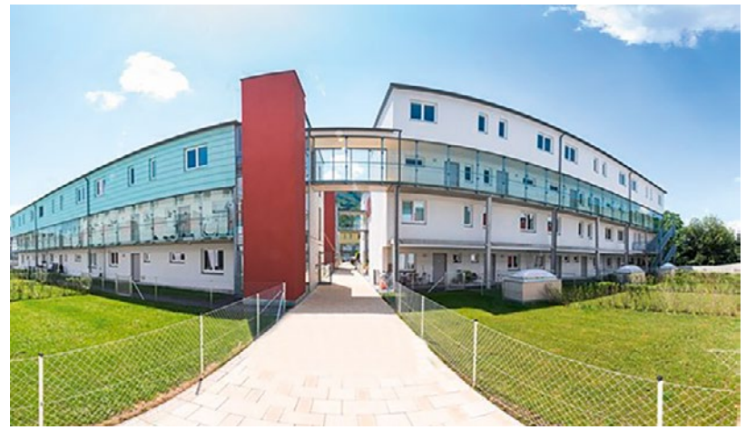
In der Vorgartenstraße bietet die Schönerer Zukunft Wohnungen in Niedrigenergiebauweise an. © Johannes Brunnbauer
