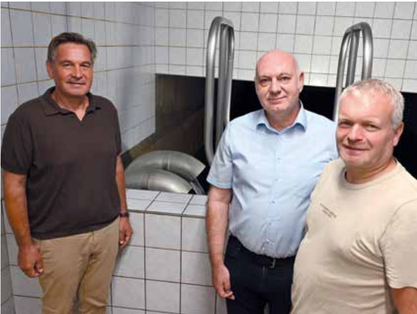
Bürgermeister Werner Krammer, Markus Hochleitner (Leiter Versorgungsbetriebe) und Infrastruktur-Stadtrat Anton Schörghofer im Hochbehälter Buchenberg.
