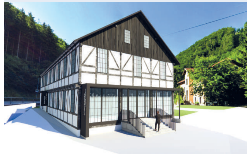
Das Fachwerkhaus in der Weyererstraße wird derzeit umfassend adaptiert und ab Ende Oktober auf zwei Geschossen genutzt.
