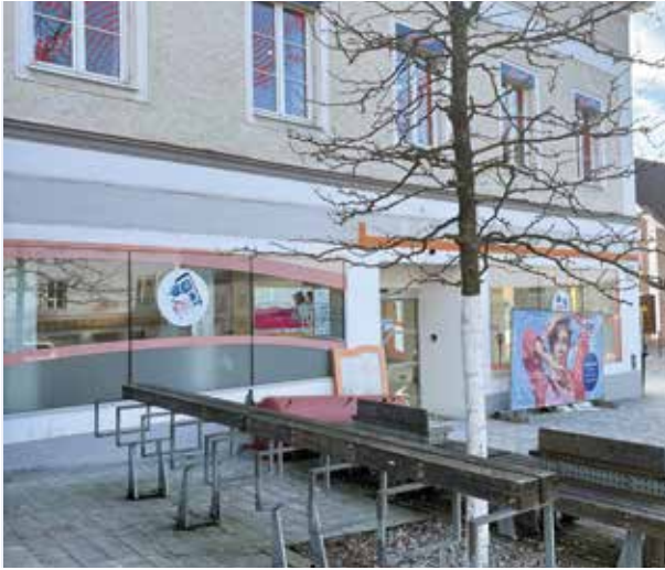
Noch wird umgebaut: dm-Markt investiert in den Standort.
