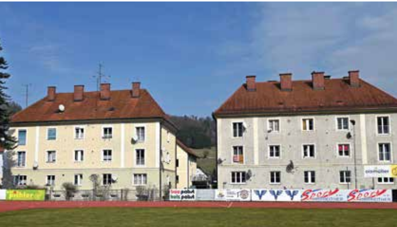
Zwei der drei Wohnhäuser, die sich in der Jahn-Gasse befinden: Ab April haben diese Gebäude mit der „Jahngasse Living GmbH“ eine neue Eigentümerin. Bestehende Mieterinnen und Mieter werden übernommen.
