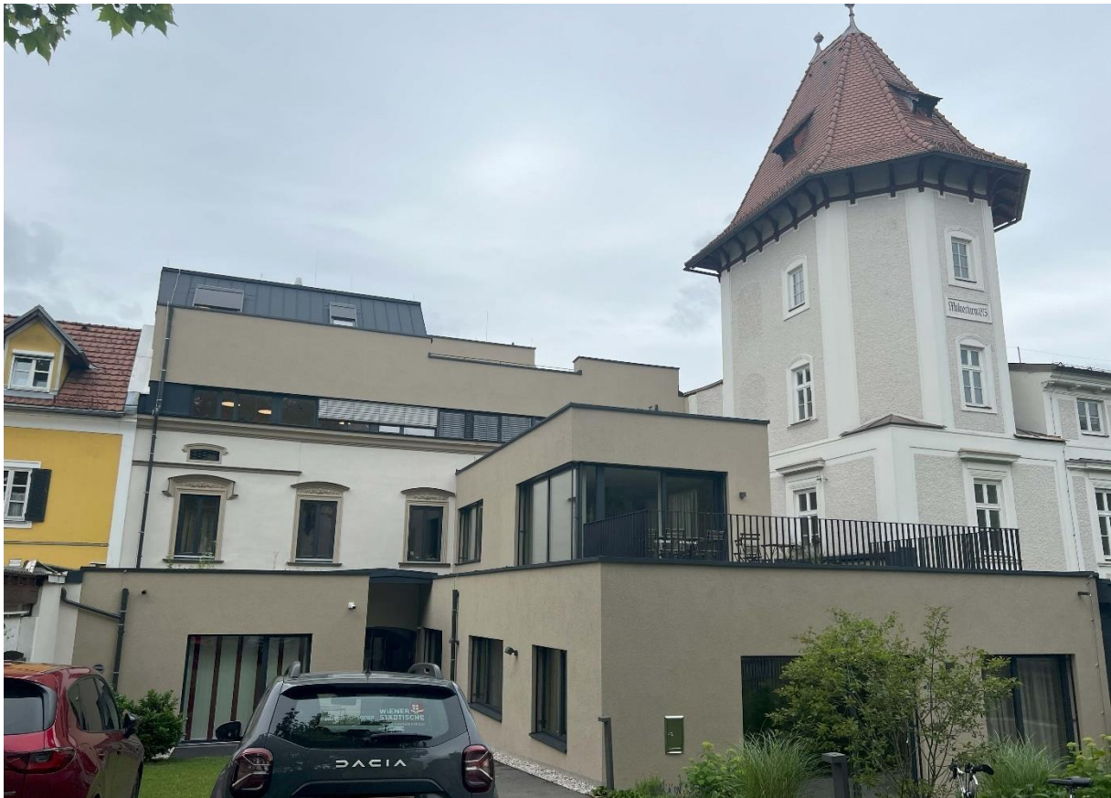
Abbildung 94: Objekt Graben 14 mit deutlichem Bruch des Ensembles gegenüber dem Bestand in Form und Linie
