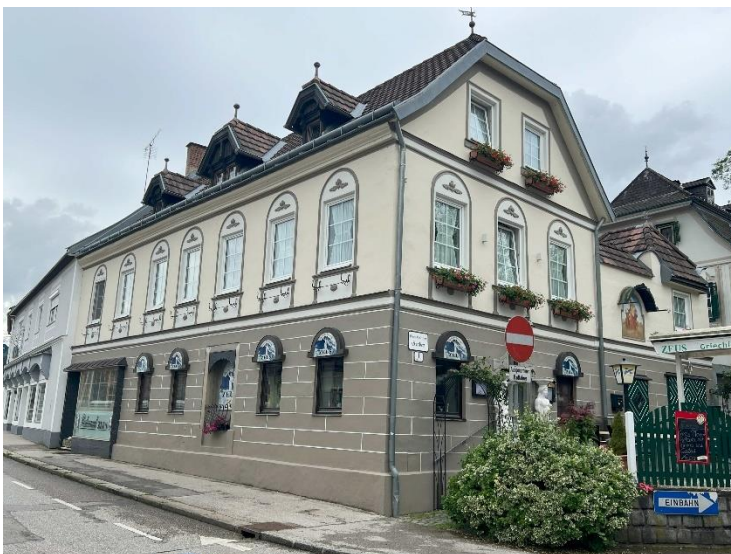
Abbildung 97: Graben I im Kreuzungsbereich zur Ybbsitzerstraße
