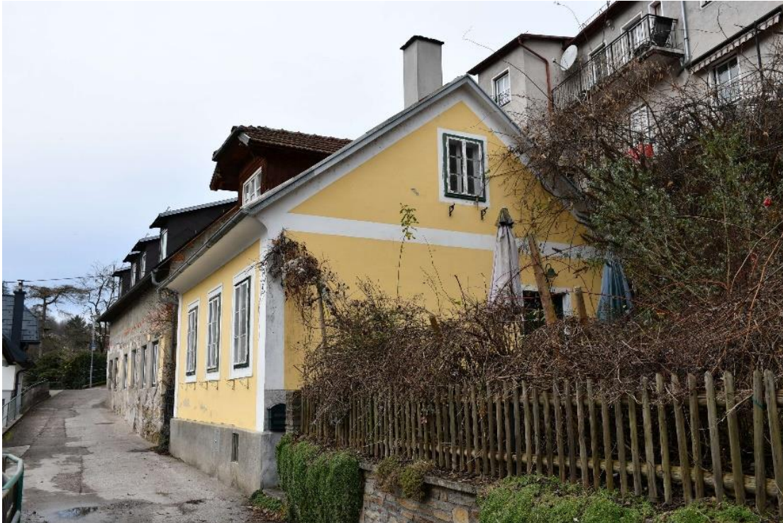
Abbildung 113: Kleinteiligkeit der Bebauung an der Ybbslände, Bsp. Häuser der Hausnummern 3 und 5
