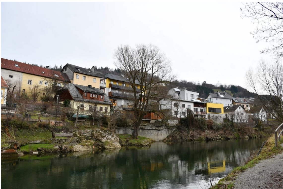
Abbildung 56: Ansicht an der Ybbs zeigt im Bereich der Ybbslände bzw. der Schmiedestraße eine starke Heterogenität in der Bebauungshöhe
