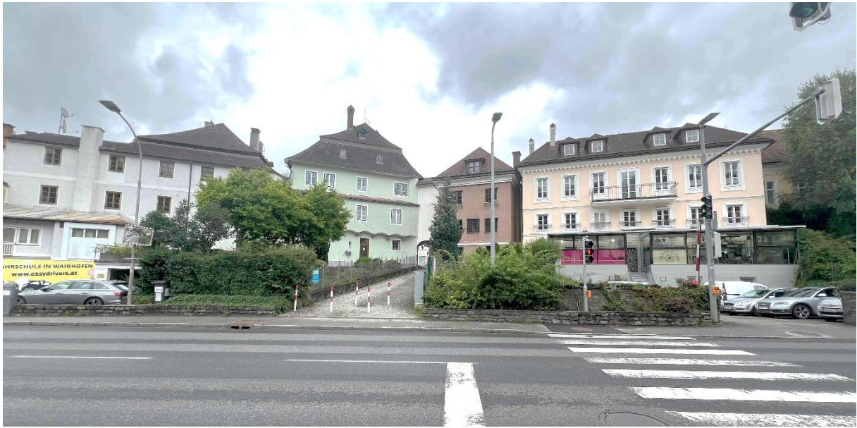
Abbildung 17: Ansicht Mühlstraße lässt die Kante der historischen Bebauung gut erkennen
