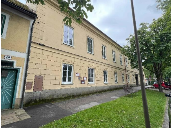
Abbildung 52: Das Gebäude, in welcher die Polizei untergebracht ist, weist ebenfalls sehr hohe Stockwerkehöhen auf
