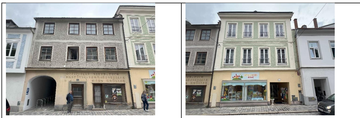
Abbildung 66: Objekte der Hr. 3 und 4 mit dreigeschoßiger Bebauung
