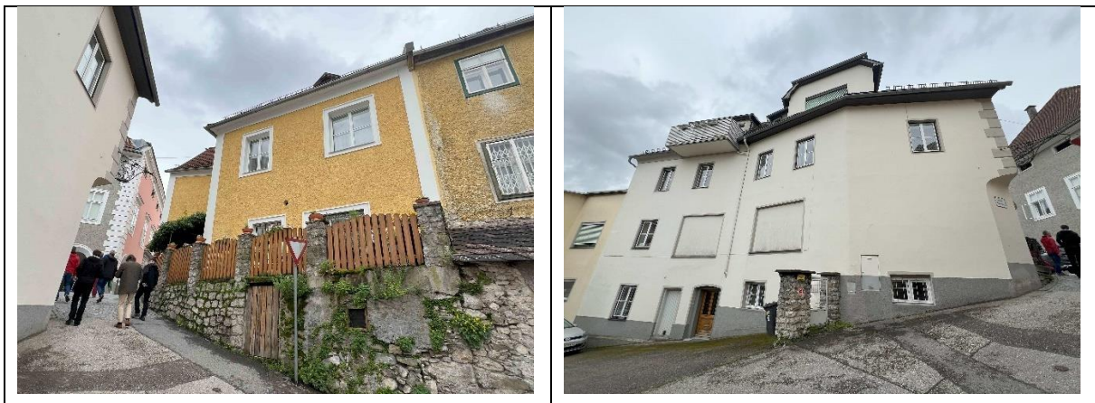
Abbildung 87: Gebäude der Ybbstorgasse von der Fuchslueg betrachtet ergibt die Bauklasse III z.T.
