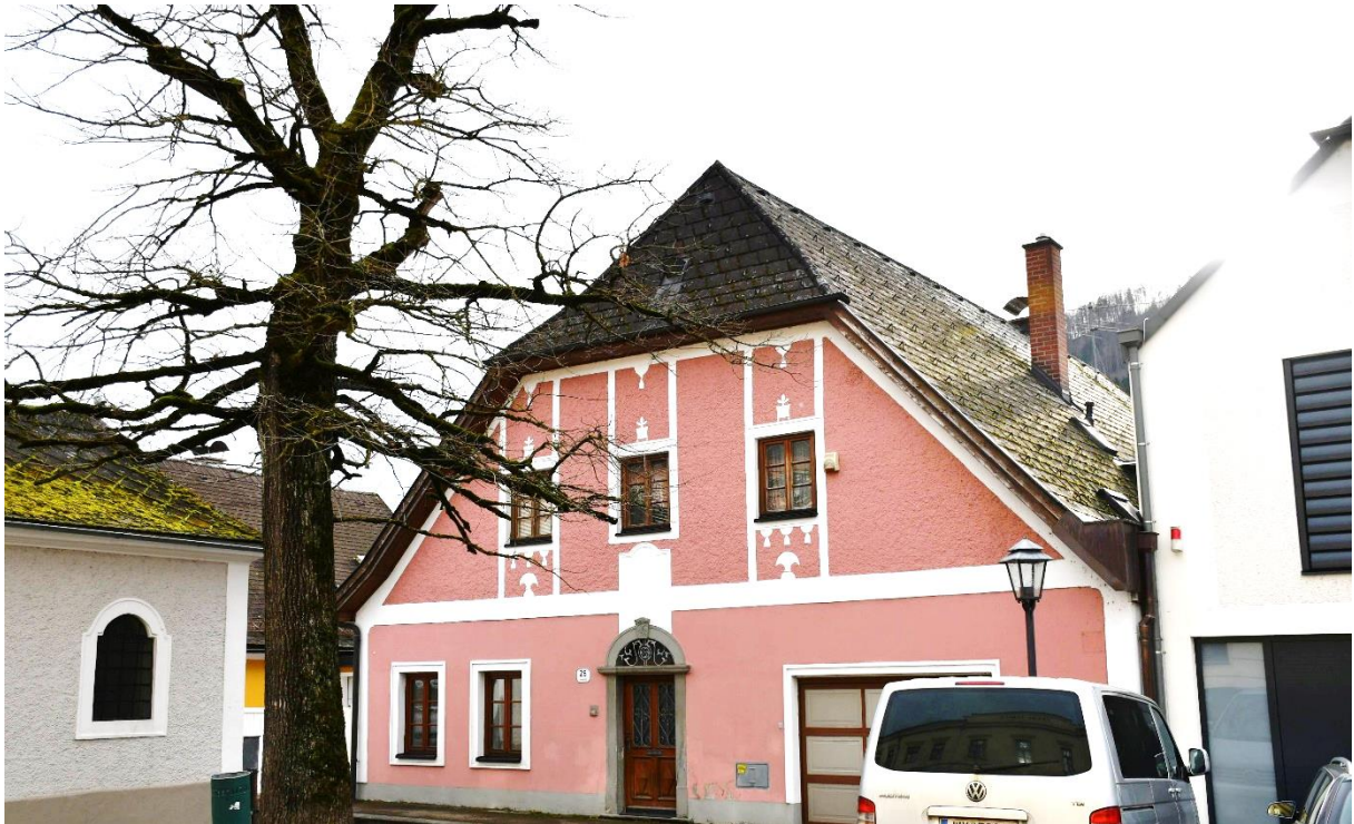
Abbildung 31: Hauptplatz 26 als besonders gut erhaltenes Exemplar, allerdings mit stilwidrigem Element einer Garage im Erdgeschoß
