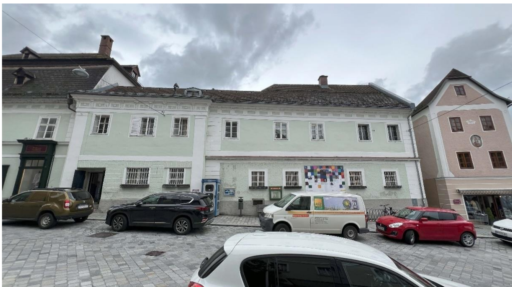
Abbildung 74: Objekte Freisingerberg 3 (rechts im Bild) und Oberer Stadtplatz 26
