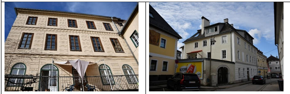
Abbildung 54: Ybbsitzerstraße 12 bis 18 (im Bild 16 und 18)
