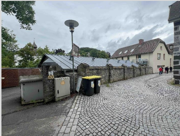
Abbildung 84: Nördlicher Bauteil an der Adresse Hintergasse 7
