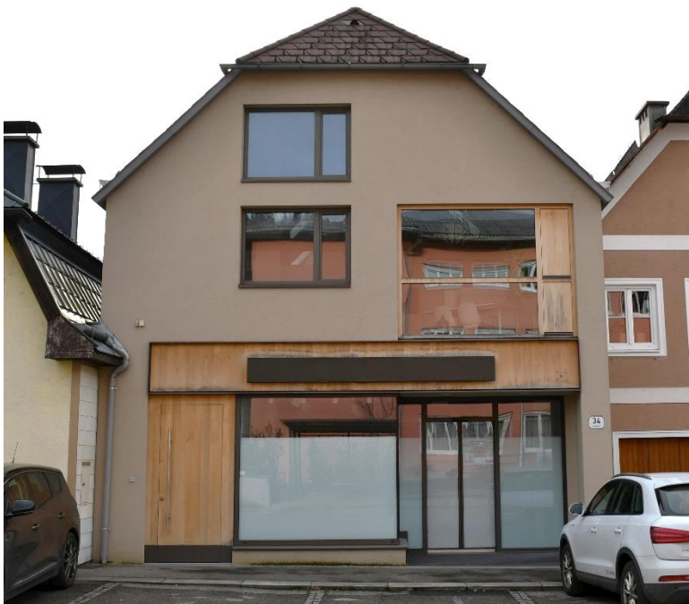
Abbildung 32: Auflösung der tradierten Fassadengliederung durch großflächige Fenster am Objekt Hauptplatz 34
