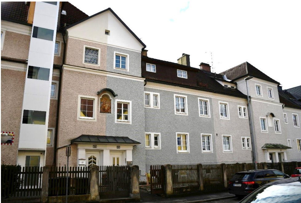
Abbildung 35: Gebäude der Ybbsitzerstraße 84 mit den erwähnten immer höher gebauten Risaliten. Aufzugsanlage links im Bild ist als stilfremd anzusprechen
