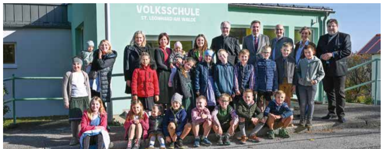
Feierliche Eröffnung: Mitte Oktober feierten die Volksschule und der Kindergarten St. Leonhard ihr neu saniertes Gebäude. Nach intensiven Renovierungsarbeiten im Sommer stand das Haus zu Schulbeginn wieder in neuem Glanz zur Verfügung.
