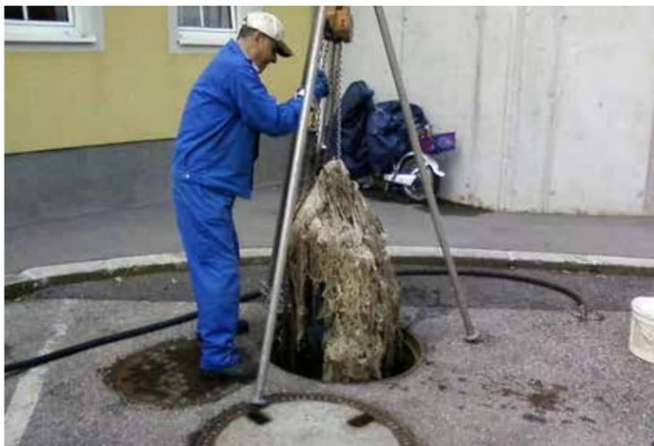
Verklumpungen wie diese entstehen aus Feuchttüchern, Tampons und Slipeinlagen, die ins WC geworfen werden. Sie legen die Pumpen der Abwasserreinigung lahm.
