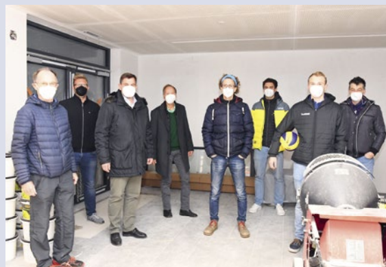
Sporthalle besichtigt: Gemeinsam mit Vertretern der Waidhofner Schulen und der heimischen Vereine besichtigte Bürgermeister Werner Krammer Ende November die Sporthalle. Die Bauarbeiten und auch die Gestaltung des Außenbereiches schreiten voran.
