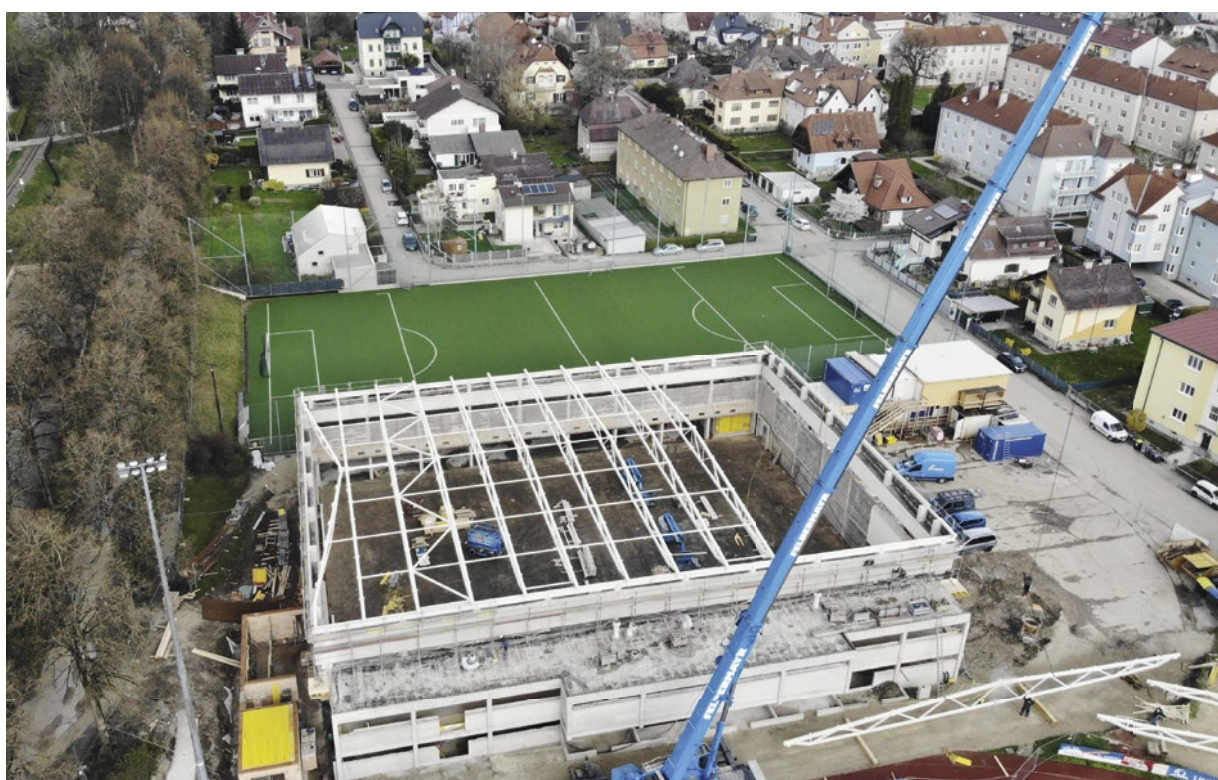
Mitte April wurde bei der Sporthalle mit der Montage der Dachkonstruktion begonnen. Mithilfe eines Kranes wurden die tonnenschweren Trägerelemente auf die Hülle aufgesetzt. Mitte Mai wurde die Dacheindeckung geliefert und mit dem Einbau begonnen.
