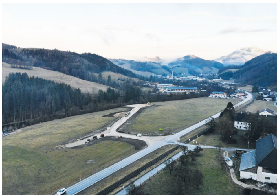
Der neue Wirtschaftspark Kreilhof gilt als ökologisches Vorzeigeprojekt. Die Infrastruktur wurde vor Kurzem fertiggestellt.
