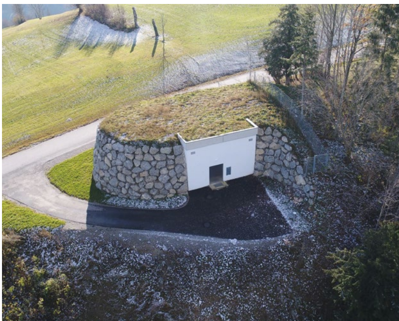
Durch den neuen Hochbehälter Obereck mit 400.000 Liter wurde die Versorgungssicherheit in Konradsheim verbessert.
