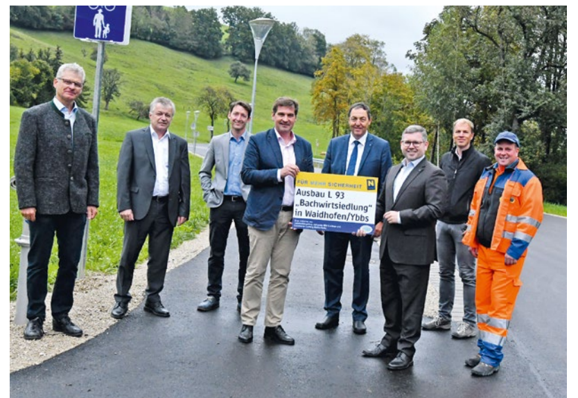
Mit dem fertigen Teilstück entlang der L93 wurde der Rad- und Gehweg bis zur Bushaltestelle ausgebaut und damit an das öffentliche Verkehrsnetz angebunden.
