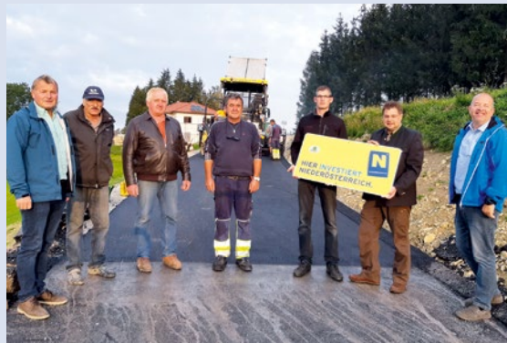
Für mehr Sicherheit: Die Zebrastreifen auf der Höhe des Restaurants „Zeus“ sowie bei der alten Polizeistation liegen auf stark frequentierten Schulwegen. Sie waren in die Jahre gekommen und wurden nun im Sinne der Sicherheit für alle Benutzer asphaltiert und neu bemalt.
