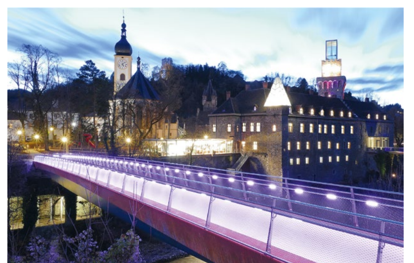
Der moderne Schlosssteg fügt sich wunderbar in die historische Umgebung ein.
