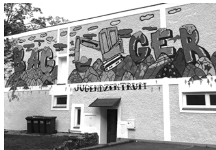
Eingang Kapuzinergasse mit neu gestalteter Fassade, Nov. 2015
